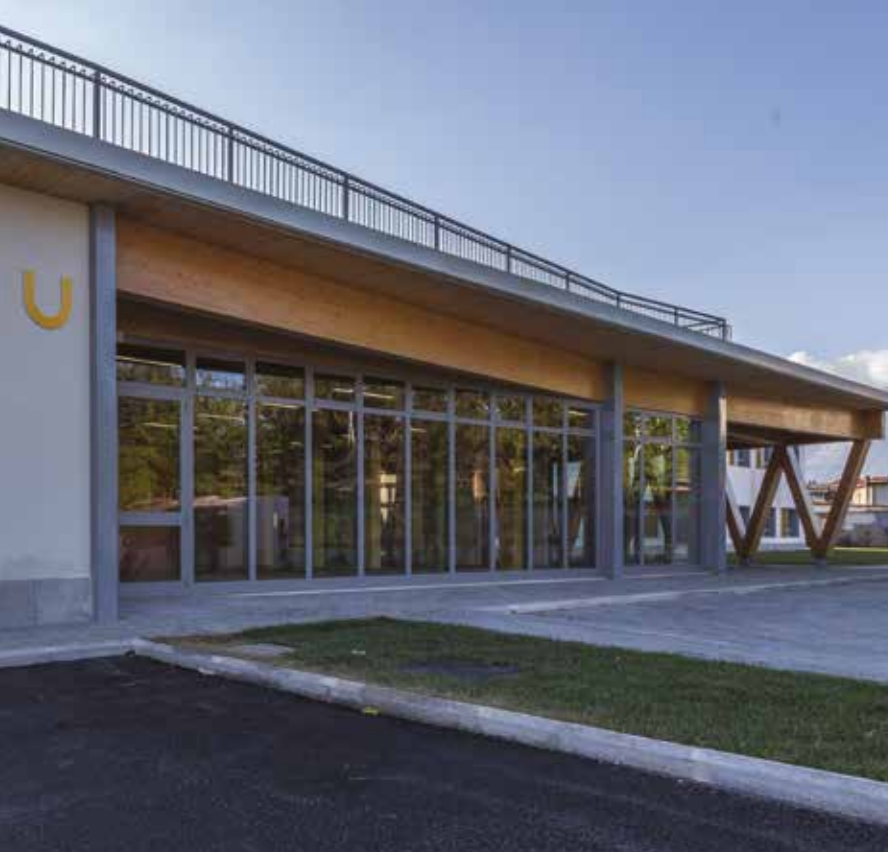
AVEZZANO (L'AQUILA) Scuola primaria "Agostino Persia", 2017
