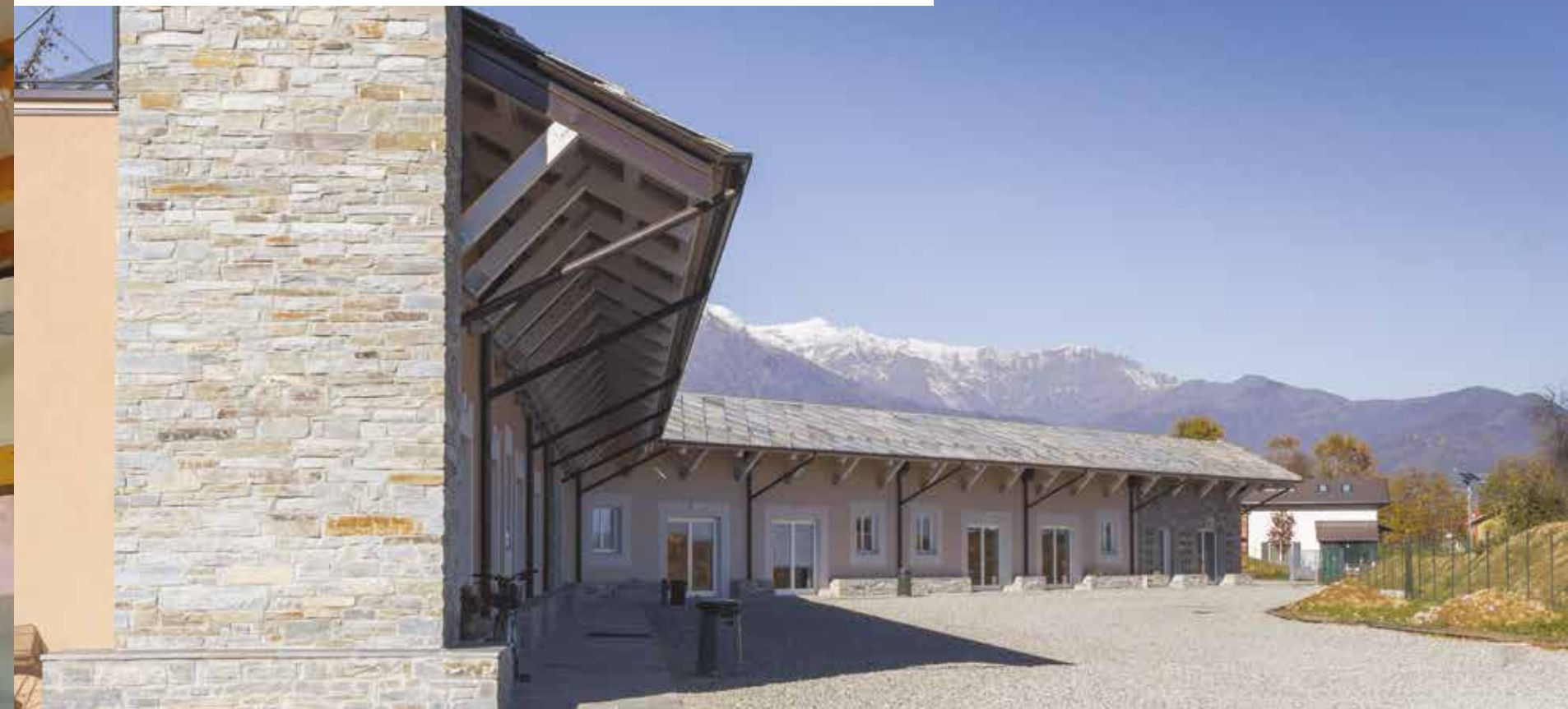
BAGNOLO PIEMONTE (CUNEO) Scuola primaria "San Giovanni Bosco", 2016
